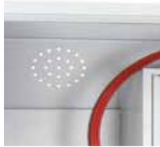
Querlüftung im Schrank durch 4 Lochmuster in der Rückwand
